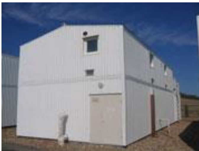
Рис. 6 Внешний вид очистных сооружений «Биоресурс»
